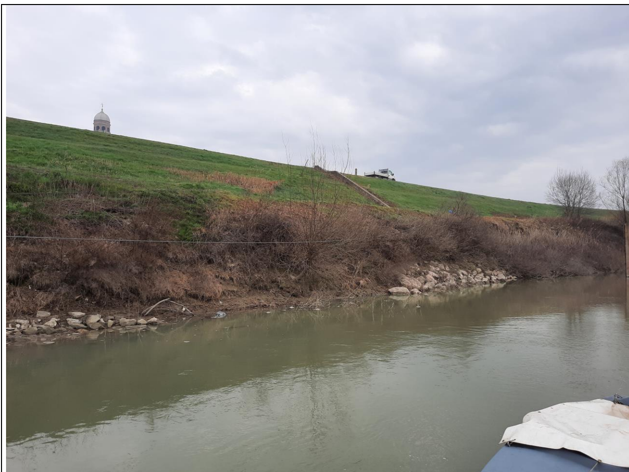
Foto n° 3 – Erosione in prossimità del pontile
