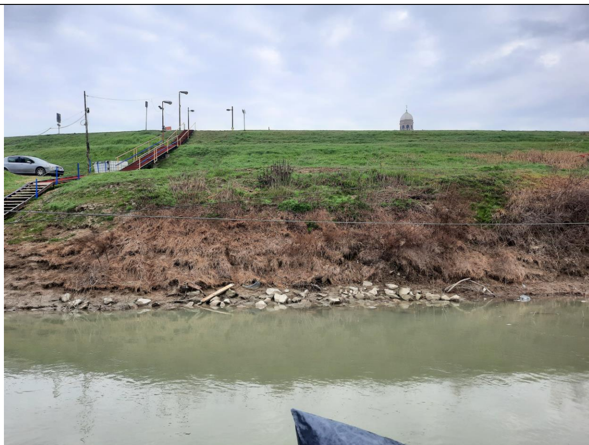
Foto n° 1 – Erosione in prossimità del pontile
