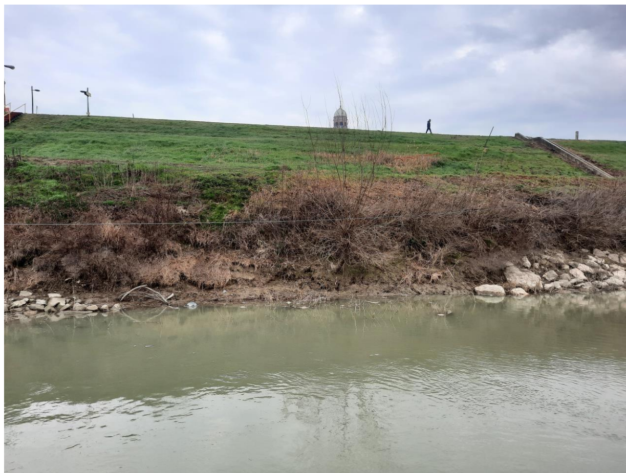
Foto n° 2 – Erosione in prossimità del pontile
